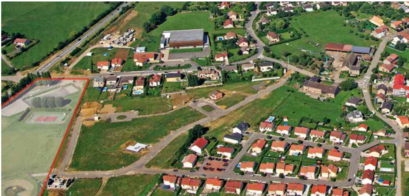
À mi-hauteur à gauche : le croisement D15 et l'entrée du village, immédiatement au-dessous, l'ancien terrain de basket et hand-ball qui sera remplacé par le parking de covoiturage. À gauche du gymnase communautaire : l'école maternelle en construction - Au milieu : le lotissement de Septfontaines en construction
