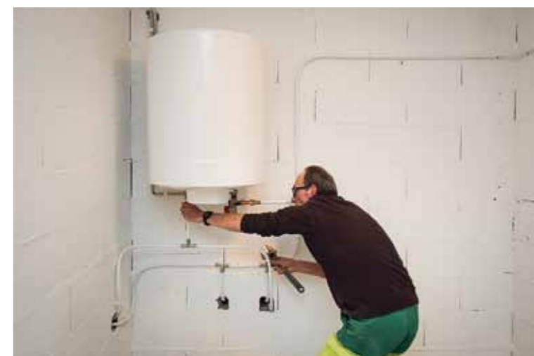
Travaux d'installation sanitaire
