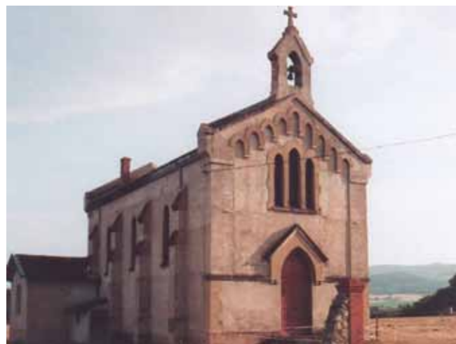
Chapelle (Loire) avant isolation extérieure (source : SPPEF)
