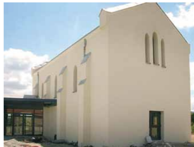
Chapelle (Loire) après isolation extérieure (source : SPPEF)
