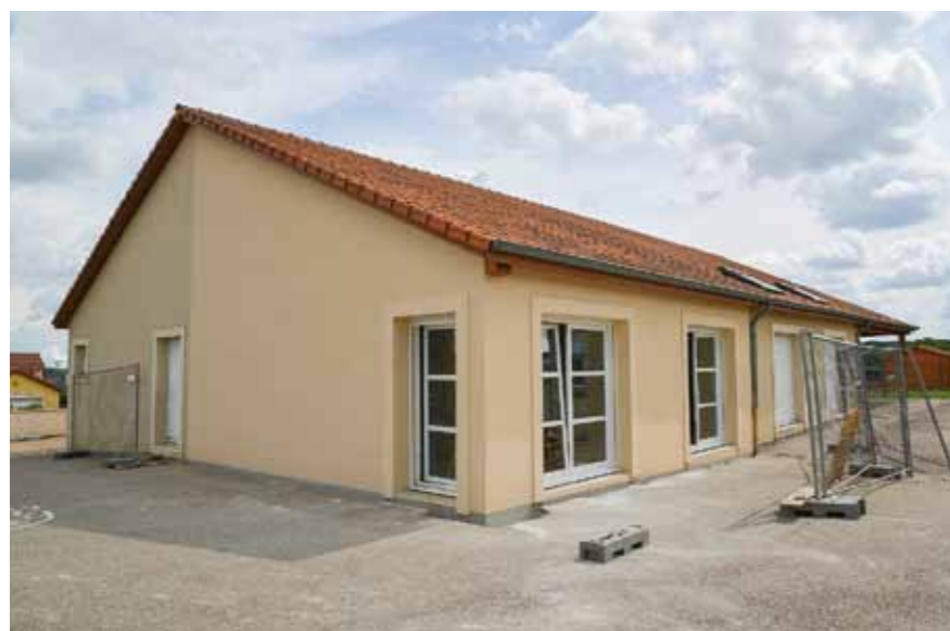
Ci-contre : La nouvelle classe de l'école primaire en cours d'achèvement
