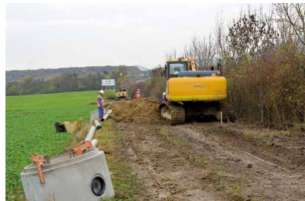
L'enfouissement des canalisations le long de l'autoroute A31 reliant Kanfen à la station d'épuration est en cours de réalisation.
