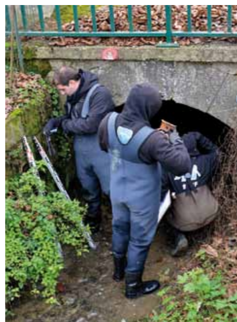
Les techniciens se préparent à explorer le passage couvert situé sous la RD56
