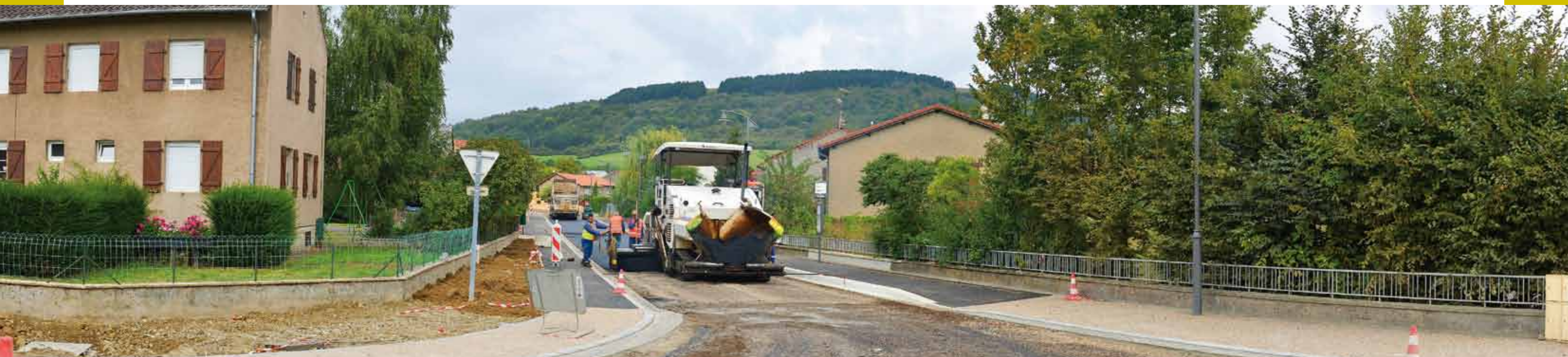
Pose de l'enrobé rue de Gaulle
