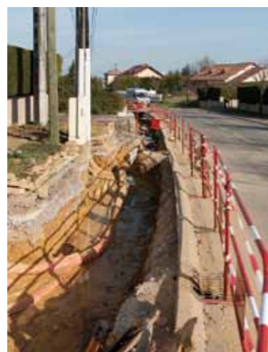
Travaux d'enfouissement des réseaux rue du Chemin de Fer et rue Robert Schuman
