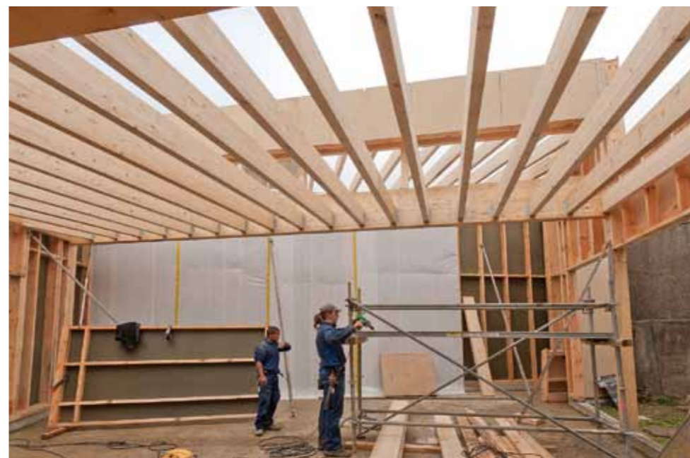
NOVEMBRE 2011 : La structure en bois est en cours d'achèvement, viendront ensuite l'isolation, le chauffage, l'électricité, etc.
