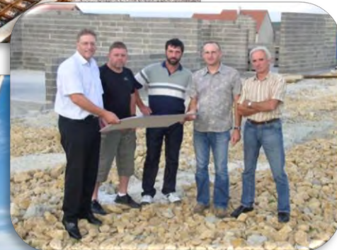
La commission des travaux surveille l'évolution du chantier
